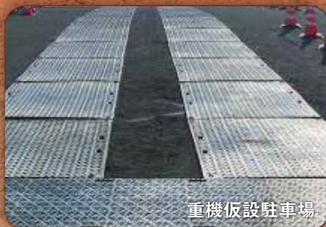
災害復興工事現場
