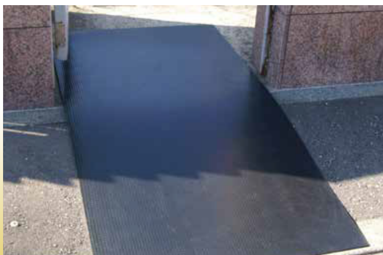
マンション工事現場の通路養生
