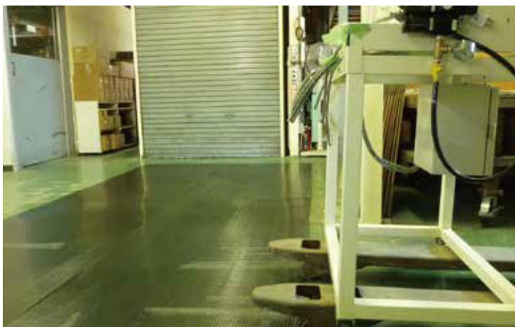
工場内の床の保護
