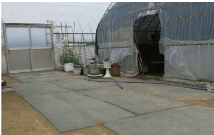
ビニールハウス入口養生
