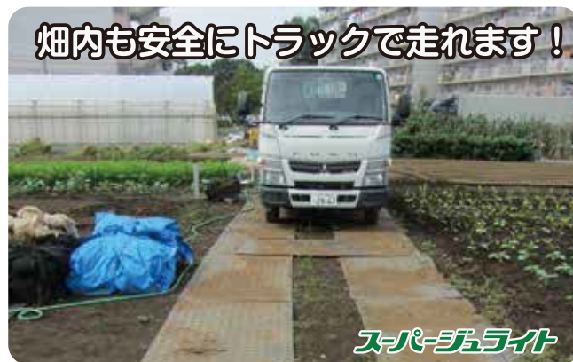
畑内路面養生
