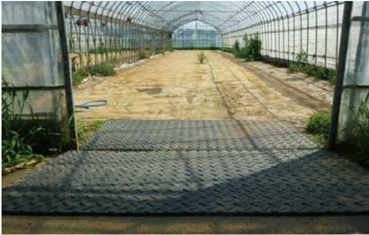
ビニールハウス入口養生
