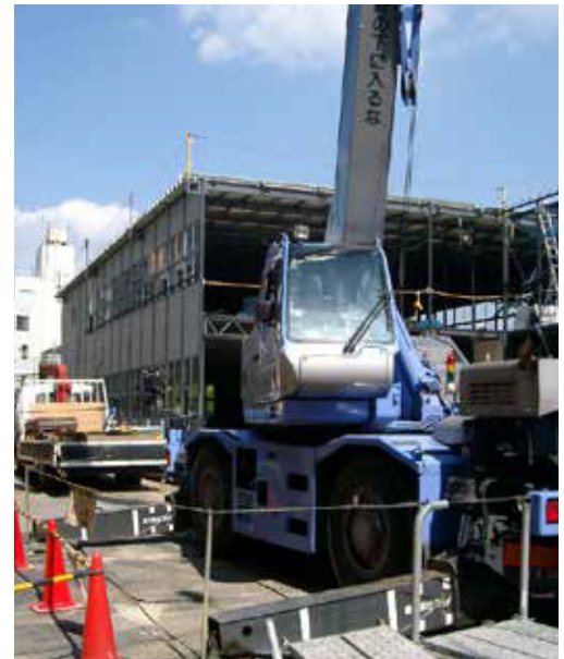
駅舎工事現場
