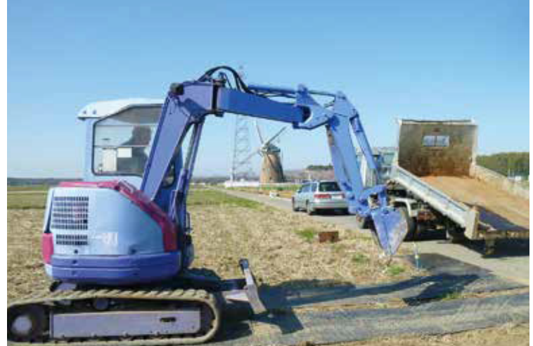
乾田内通路養生
