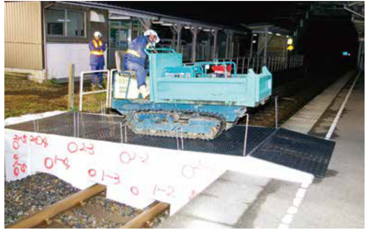
J Rホーム横断工法に使用
