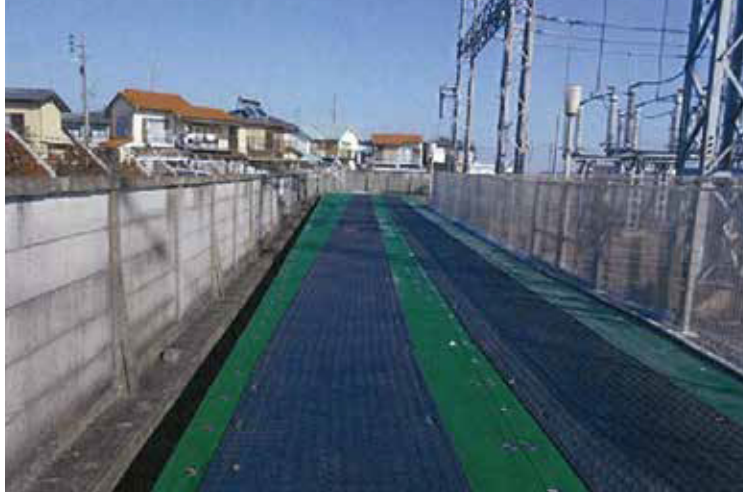
電力会社 変電所敷地養生
